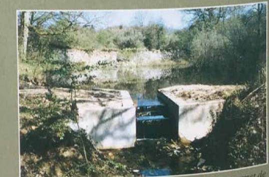
L'ouvrage est terminé. Le batardeau est enlevé et permet de remblayer et compacter la digue. Les planches sont en place.
