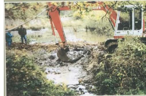
Creusement des fondations, enlèvement de l'ancien ouvrage et des vases à l'aval du batardeau.
