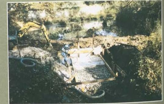
Les fondations sont hors d'eau. Installation du coffrage. Les matériaux sont apportés par une chenillette. Une pompe est prévue pour vider l'eau en cas d'intempéries.
